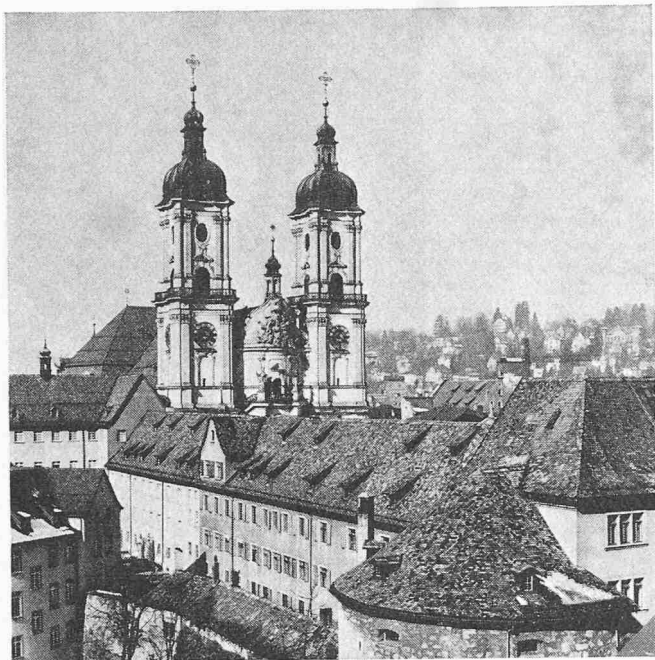
Die Kathedraltürme St. Gallen. Im Vordergrund das ehemalige Konventgebäude mit Resten der Stadtbefestigung und dem letzten Wehrturm (Foto Dr. W. Lendi, St. Gallen)
