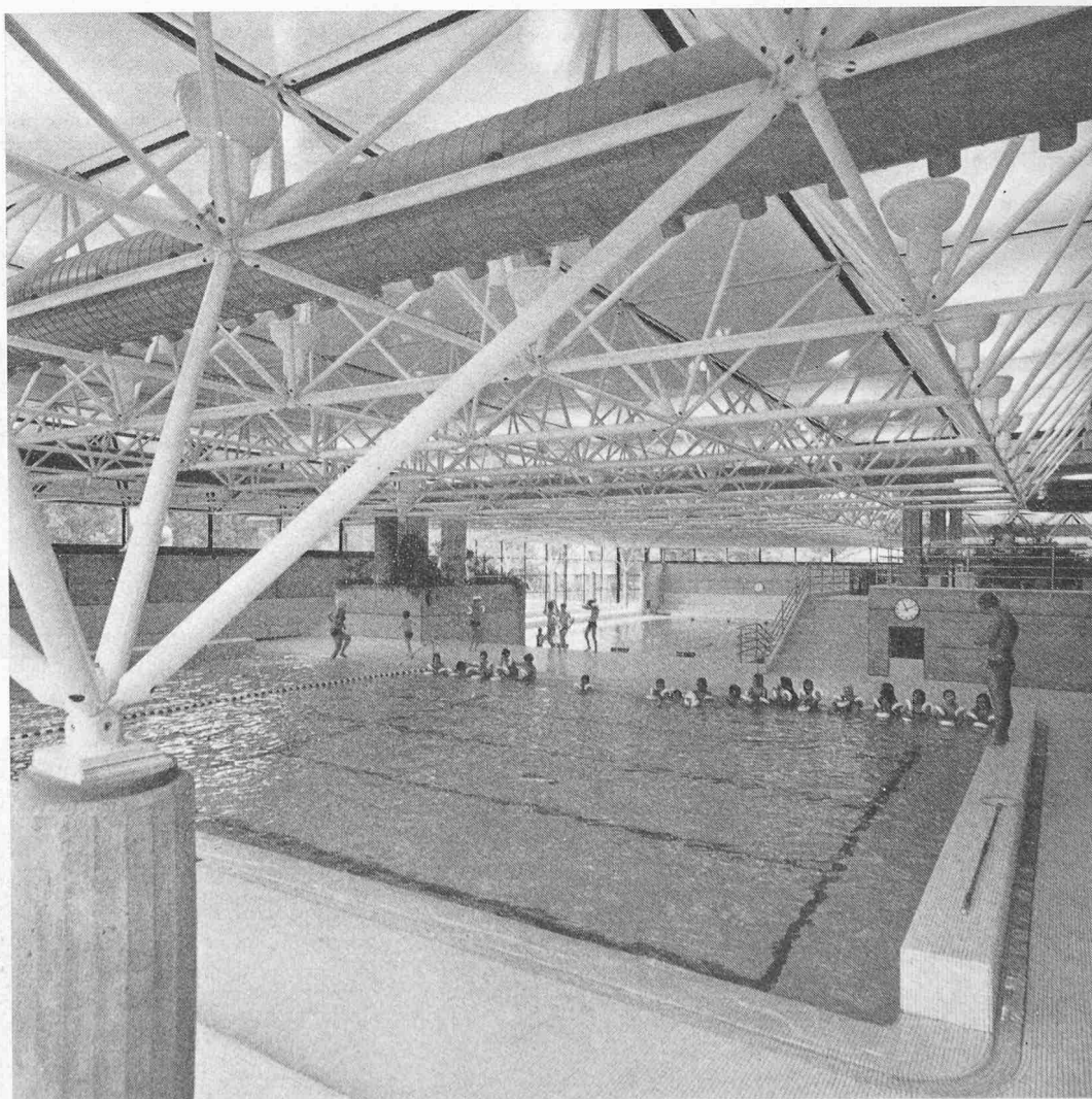
Nichtschwimmerbecken mit Durchblick ins Schwimmerbecken, links im Hintergrund Verbindungsteil mit Hauptlüftungsrohre, rechts Restaurant
