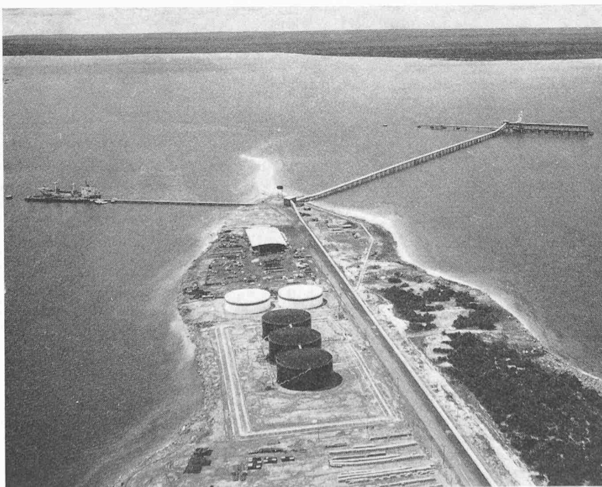
Bild 1. Hafenanlagen, Übersicht. Im Vordergrund Tanklager für Heizöl und Natronlauge
