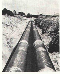
Bild 2. PAN-ISOVIT-Leitung in der Bauphase (Schweden)
