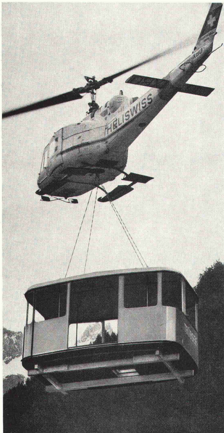
Kabinen-Transport der Trübsee-Titlis-Bahn
