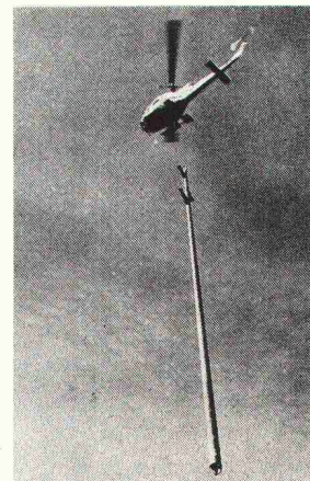
Transport eines Mastes
