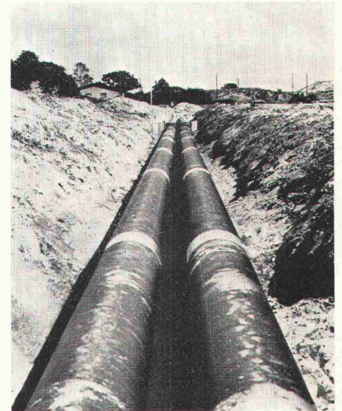
Bild 2. PAN-ISOVIT-Leitung in der Bauphase (Schweden)
