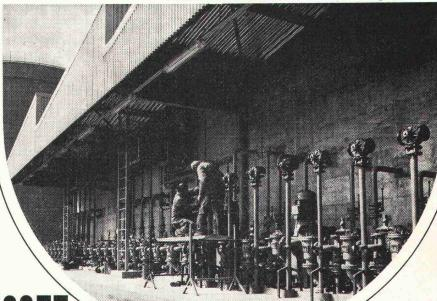
Die horizontalen Lager- Die gewählten selbsttanks müssen also mit Pumpen und Rohrleitungen bestückt werden, die mit all diesen Problemen fertig werden. Ein paar wenige Flüssigkeiten können per Schwerkraft eingelagert werden – für alle andern müssen total 28 Pumpen installiert werden.
