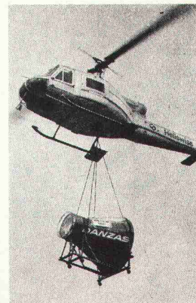
Einbringen von Frischbeton
