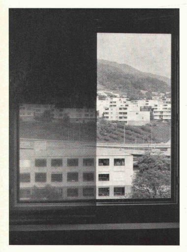
keine Wärme an den dahinterliegenden Raum abgeben kann. Es war die Idee, einen Sonnenschutz zu entwickeln, der nicht mehr aufwendige Aussenmontagen, platzbeanspruchende und den Bau verteuernde Lamellenkasten sowie komplizierte Bedienungsmechanismen benötigt. Auch die Probleme der störenden Geräusche und der ständig zunehmenden Verschmutzung mussten umgangen werden.
