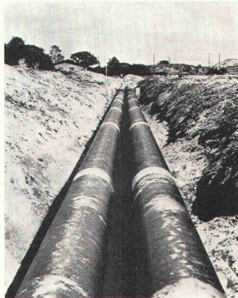
Bild 2. PAN-ISOVIT-Leitung in der Bauphase (Schweden)
