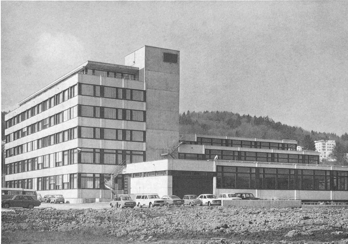
Nordwestansicht von Administrationstrakt, Anlieferkoje und Ateliers
