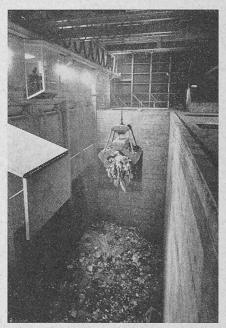
Blick in den 1850 m<sup>3</sup> fassenden Kehrichtbunker, von dem aus die beiden Verbrennungsöfen beschickt werden
