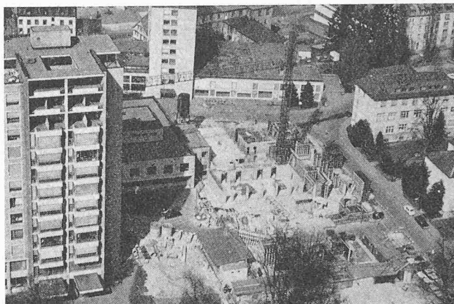
Bild 3. Bauzustand April 1972. Die grossflächige Schalung für Wandscheiben und Liftschächte ist erkennbar
