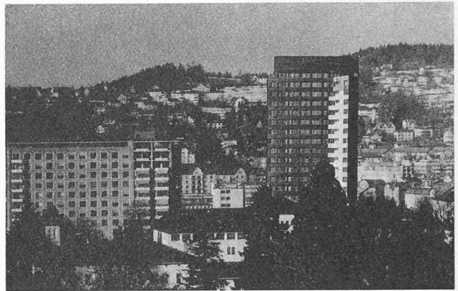
Photomontage: Bestehende Chirurgische Klinik (links) und Hochhaus 2 (rechts, im Bau)
