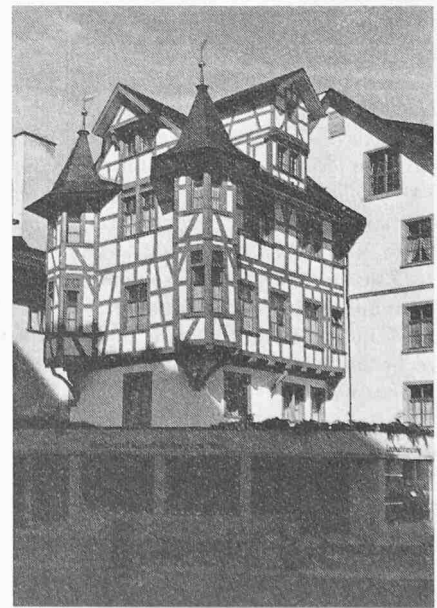
Bild 7. Gallusstrasse 20 («Blaues Haus») Fachwerkbau aus dem 16. Jh. 1971 restauriert von Architekt Oskar Müller und Denkmalpfleger Walter Fietz
