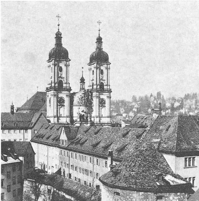
Bild 2. Im Vordergrund das ehemalige Konventsgebäude mit Resten der Stadtbefestigung und dem letzten Wehrturm. Dahinter die Kathedrale
