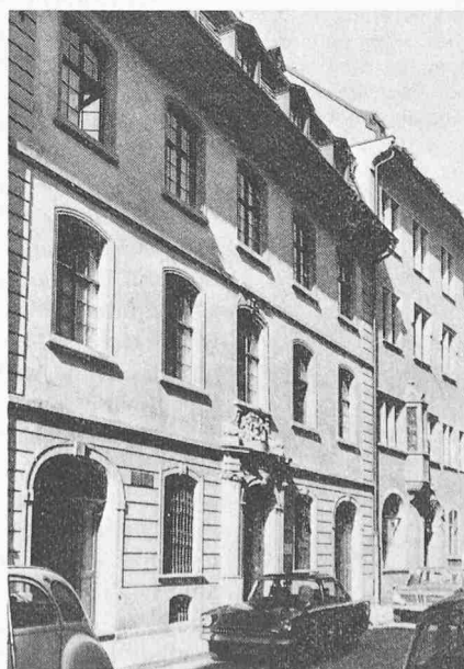
Bild 10. Gasse Hinterlauben. Das Haus Nr. 8 («Zum goldenen Apfel») mit originalem Interieur. Neuentdeckte Malereien 1961 bis 1963 von Walter Vogel restauriert [7]
