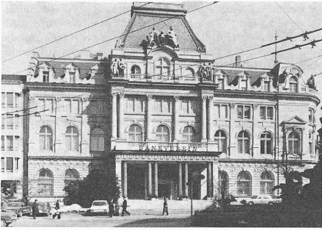
Bild 20. Oberer Graben 17 (Schweizerischer Bankverein). Erbaut 1890 von Architekt C. Forster
