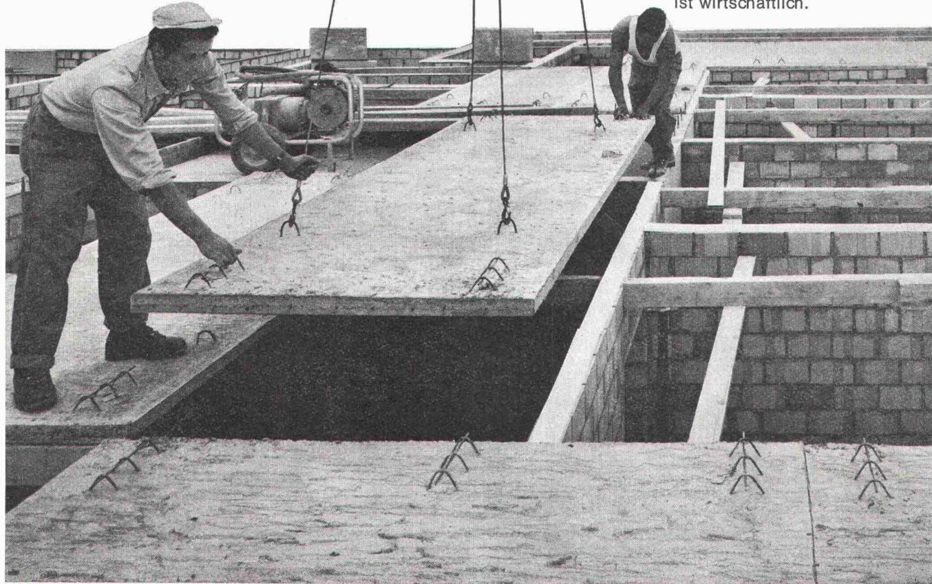
Prelam Deckenplatten sind vorgefertigt und werden am Bau verlegt. Sie übernehmen die Funktion der Deckenschalung und wirken als Träger der vorgespannten Hauptarmierung.
