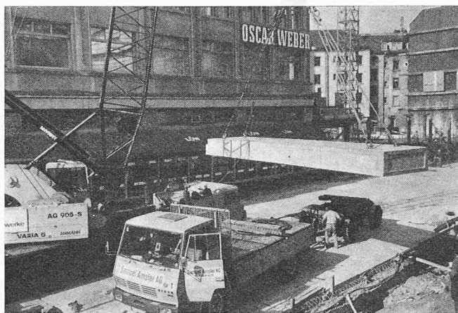
Bild 7. Antransport der 26 t schweren Fahrbahnplatten für die Abdeckung der Usterstrasse
