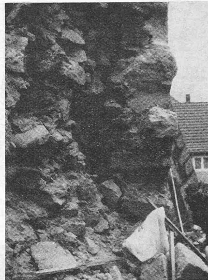
Bild 7 (links). Die am 5. November 1971 eingestürzte talseitige Längswand des Ostraktes der Burg von ausserhalb der Stadt her gesehen
