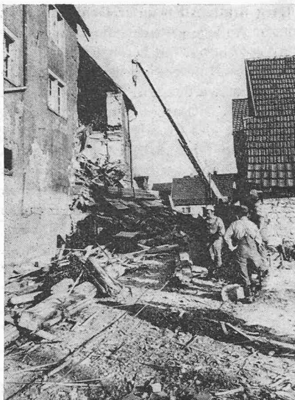
Bild 7 (links). Die am 5. November 1971 eingestürzte talseitige Längswand des Ostraktes der Burg von ausserhalb der Stadt her gesehen
