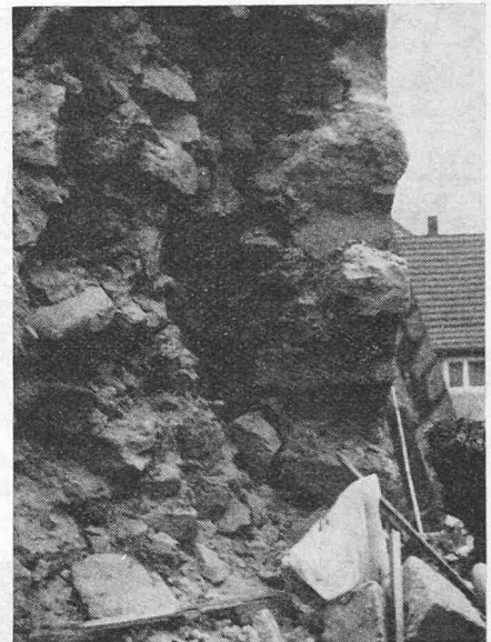
Bild 7 (links). Die am 5. November 1971 eingestürzte talseitige Längswand des Ostraktes der Burg von ausserhalb der Stadt her gesehen
