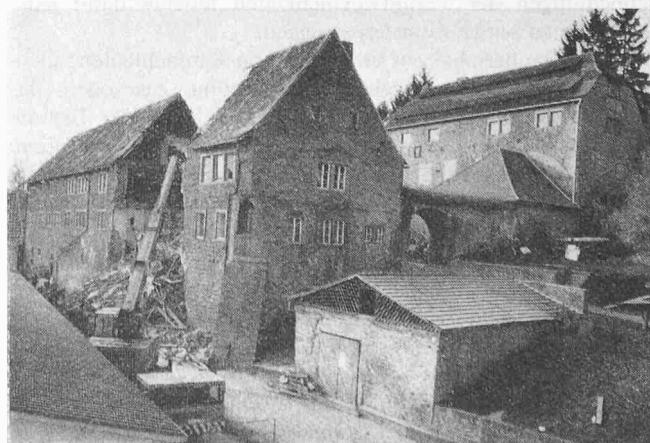
Bild 2. Die Burg Brattenstein nach dem Einsturz vom 5. Nov. 1971
