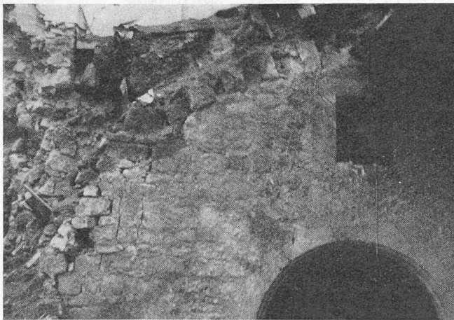
Bild 4. Die in Bild 6 mit B bezeichnete Querwand in Richtung C gesehen. Diese Wand hat vor 1640 den älteren Teil des Ostraktes der Burg als Giebelwand abgeschlossen
