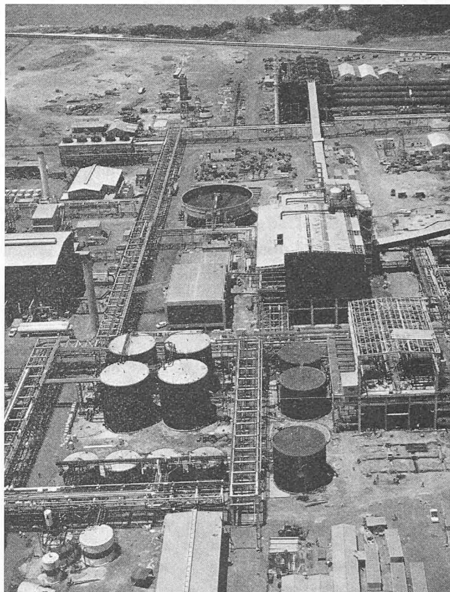
Bild 5. Hydrat- und Sicherheitsfiltrationsgebäude
