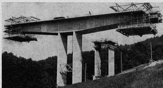
Bild 1. Im Freivorbau erstellte Überbauten der Brücke bei Belmont nahe Lausanne für die Nationalstrasse N9
