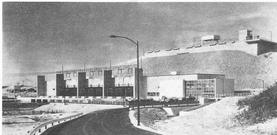
Bild 4. Das Flusskraftwerk Grand Rapids, Fallhöhe 37 m, installierte Leistung 460 MW
