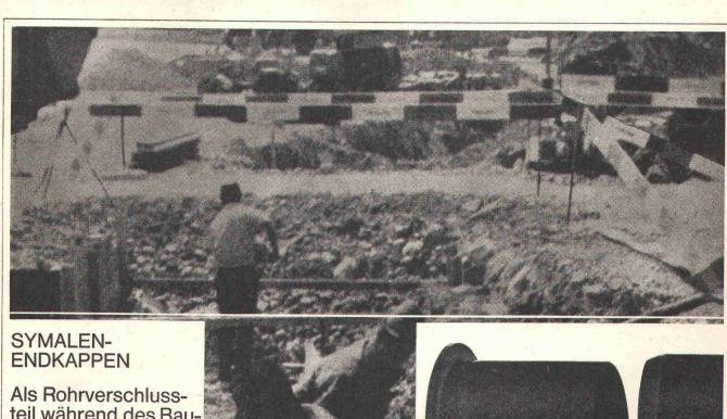
Als Rohrverschlussteil während des Bauvorganges oder als Rohrendverschluss bei Reserveleitungen verwendbar.
