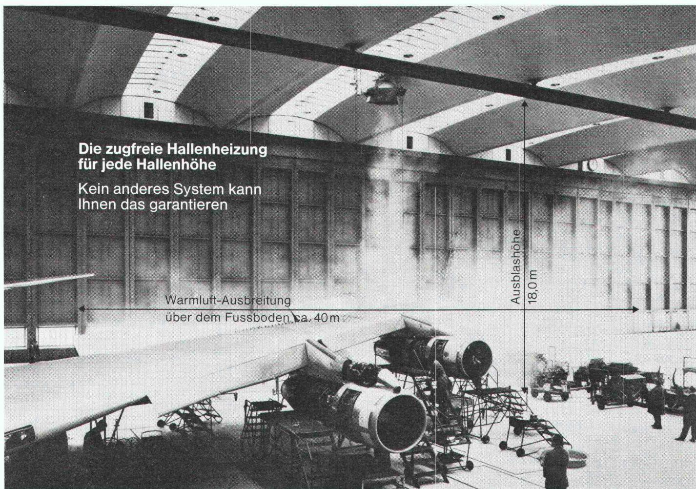
Diese Aufnahme zeigt deutlich, wie sich die Warmluft über dem Fussboden (und nicht an der Decke) ausbreitet.
