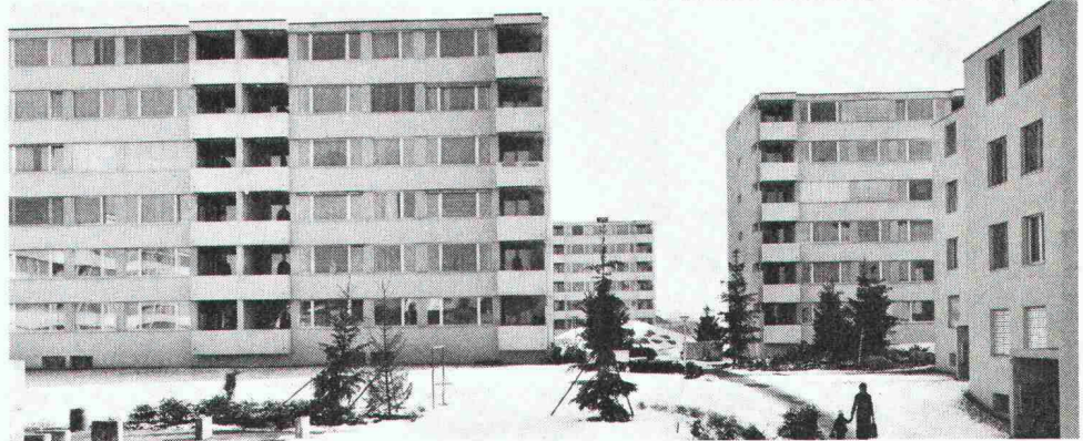
Überbauung Rain, Jona SG
