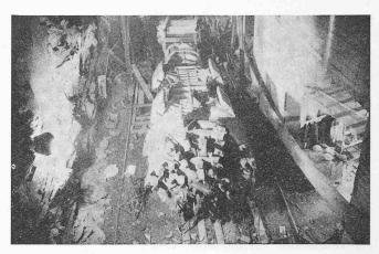
Gotthard-Strassentunnel, Montage der Tunnelbohrmaschine bei Motto di Dentro
