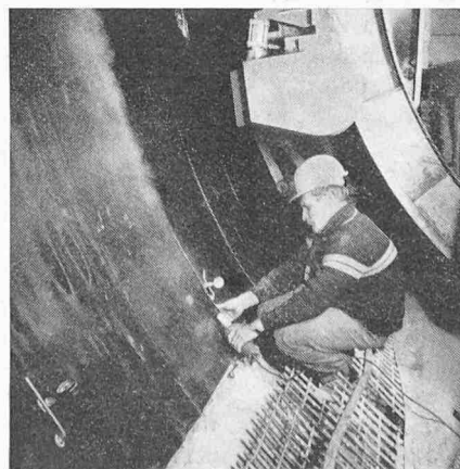
Bild 6 (rechts). Manometer und Luftventil für die Luftdruckprüfung der Doppelschweissnaht
