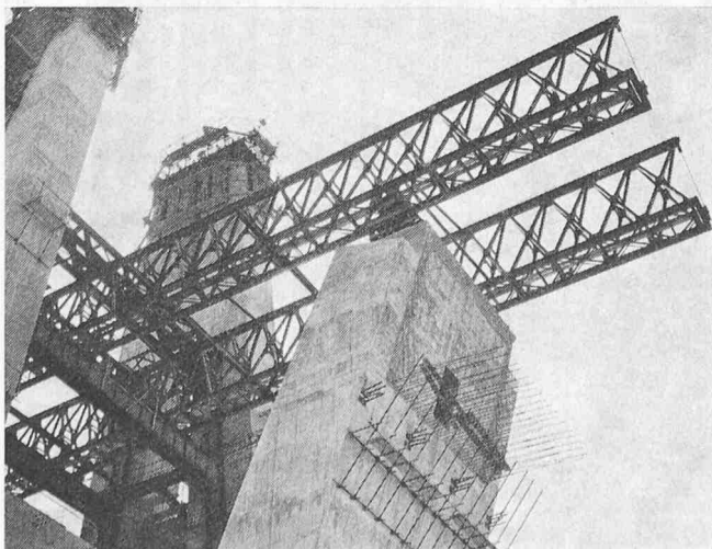
Bild 15. Lehrgerüststräger für den Bau des Brückenabschnittes zwischen den Schrägstützen. Links der Stützbock, an welchem die beiden Träger je zweifach aufgehängt sind. Unter den Anschlussstählen an der Schrägstütze für den Brückenkastenboden sind die 4×4 Spannstellen der provisorischen Zugglieder
