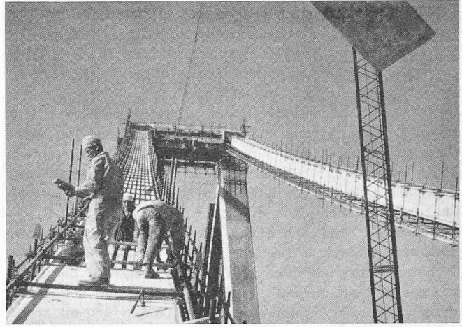
Bild 33. Fertigstellen der Zugbandkonstruktion. Aufkleben der Deckel mit Epoxyharz-Mörtel (vergleiche Bild 34)
