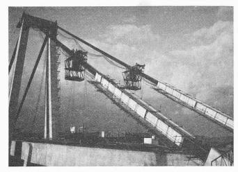
Bild 32. Montage der Zugbandelemente mit den beiden Hilfsvorrichtungen. Auf der Brückenoberfläche liegt die mobile Schienenkonstruktion, auf welcher die Tragplattformen stehen. Sichtbar sind die unteren Reihen der Kabel für die Eigenvorspannung, welche an die darüberliegenden 11/8"-Litzen gebunden sind
