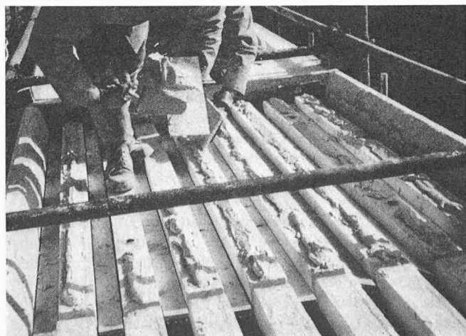
Bild 34. Aufbringen des Epoxyharz-Mörtels zum Kleben des Deckels auf das Zugbandelement. Sichtbar sind drei der vier Hülsen mit Innenrinne, welche den Deckel mittels vier Bolzen festhalten
