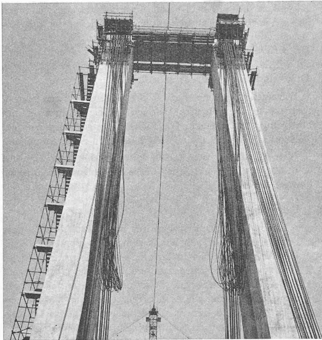
Bilder 21 und 22. Blick von der Brückenfahrbahn gegen die Turmspitze. Man erkennt die Schlaufen der ersten Serie provisorischer Tragseile
