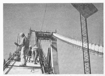
Bild 33. Fertigstellen der Zugbandkonstruktion. Aufkleben der Deckel mit Epoxyharz-Mörtel (vergleiche Bild 34)
