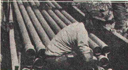
DOPPELMUFFEN MIT PROFILGUMMRINGEN Das ideale Verbindungselement für SYMALEN- und SYMADUR-Kabelschutzrohre. Der Profilingummiring gewährleistet ein dichtes Rohrleitungssystem. Vor dem Aufschieben der Doppelmuffe auf das Rohr muss das angeschragte Rohr mit Glimmöl bestrichen werden.
