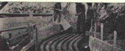
EINFÜHRUNGS- ROHRE (aus Asbestzement) Wasserdichte Mauerdurchführung für SYMALEN-Kabelschutzrohre.
