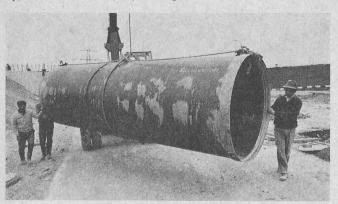
deckung und den Autobahnverkehr, erforderlich. Dabei wurde die grosse Steifheit der Rohre (ein Aussteifen gegen Verformung ist nicht notwendig) sehr geschätzt. Die Art der Rohrverbindung (Rollringmuffe) garantiert die Dichtheit und erlaubt gleichzeitig eine leichte, genaue und schnelle Verlegung.
