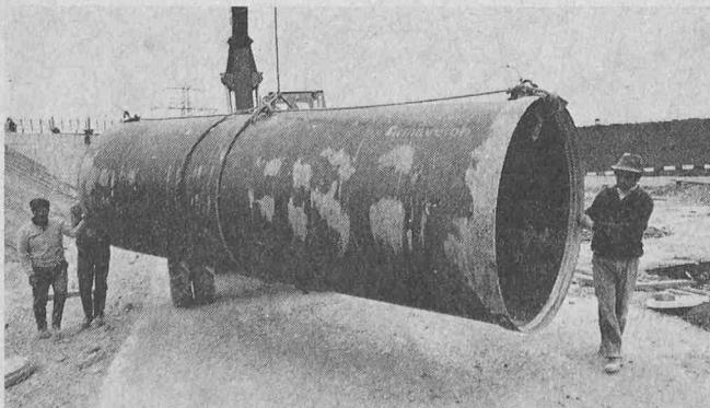
deckung und den Autobahnverkehr, erforderlich. Dabei wurde die grosse Steifheit der Rohre (ein Aussteifen gegen Verformung ist nicht notwendig) sehr geschätzt. Die Art der Rohrverbindung (Rollringmuffe) garantiert die Dichtheit und erlaubt gleichzeitig eine leichte, genaue und schnelle Verlegung.
