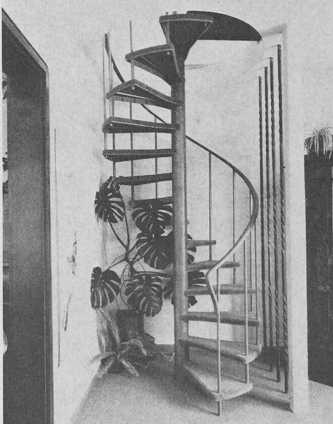
aus, das die Höhe einer Stufe besitzt. Bei der Montage steckt man die Distanzrohre auf die Mittelsäule und bringt, mittels einer Arretierung, die Stufen in den richtigen Winkel. Durch die Montage im Baukastensystem kann die Treppe jeder Geschosshöhe angepasst werden.
