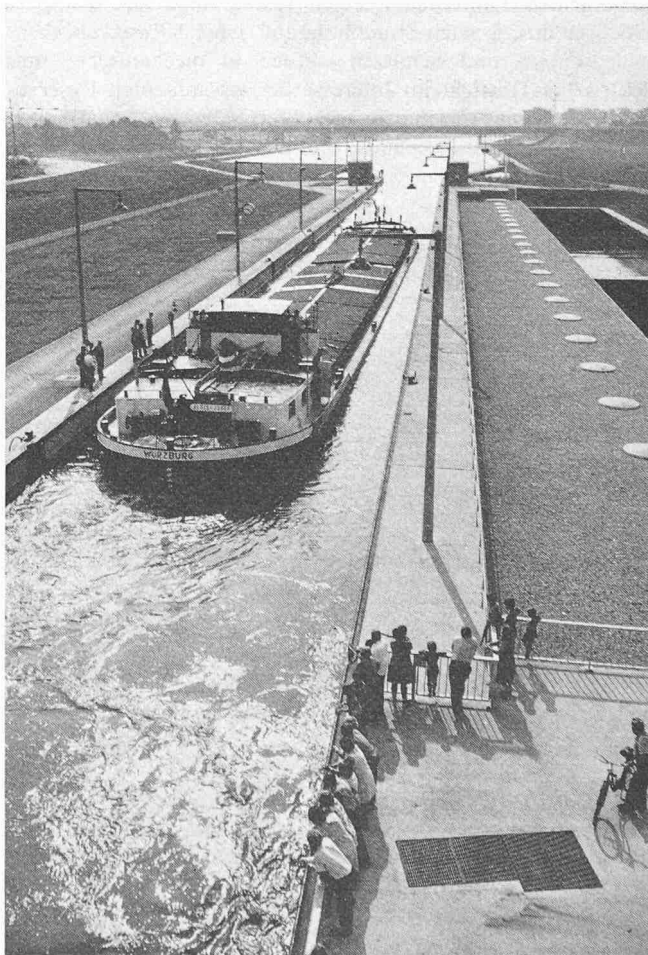
Bild 3. Schleusung eines Frachtbootes
