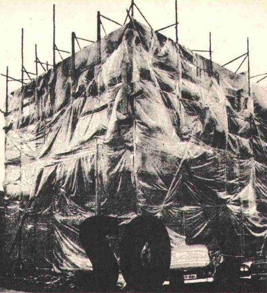
**HOWAG**aine - Folien aus Polyäthylen ermöglichen die Weiterführung der Arbeiten auch bei Kälte, Regen und Schnee. Diese Folien eignen sich auch vorzüglich als Abdeckmaterial bei Strassenbauten, für Trennwände und Schallisolation, beim Betonieren, für Barackenbau, Notdächer usw. Howagaine-Folien sind isolierend, durchsichtig und säurebeständig.
