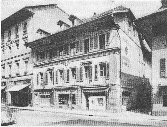
Das Tscharnerhaus an der Amtshausgasse in Bern, 1735
