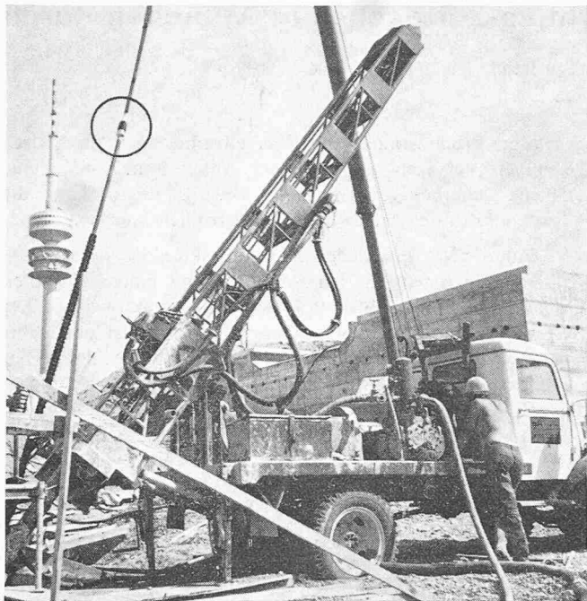
Bild 3. Das Einbringen der Injektionszuganker Stump-Duplex. Die Bohrlafette ist auf einem Lastwagen montiert. Am Ausleger eines Autokrans hängt der Erdanker. Im Kreis ist die Stump'sche Ankerblase zu erkennen. Im Hintergrund der Fernsehturm
