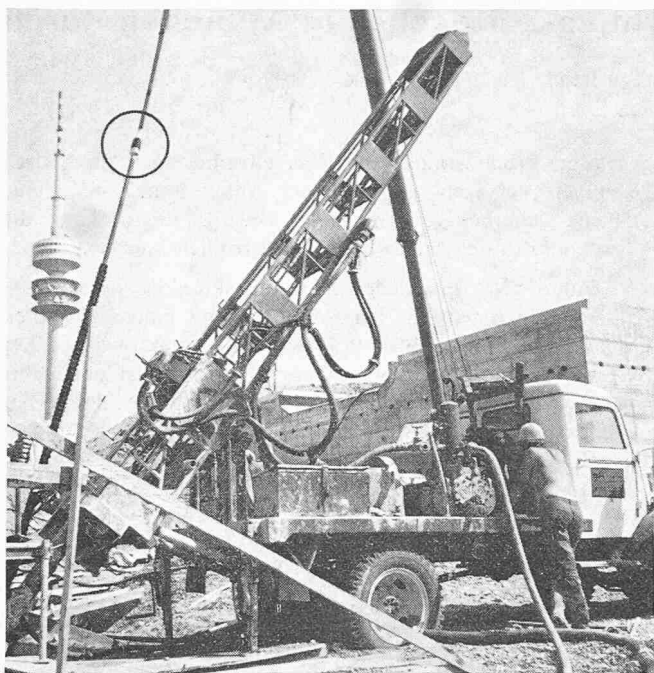
Bild 3. Das Einbringen der Injektionszuganker Stump-Duplex. Die Bohrlafette ist auf einem Lastwagen montiert. Am Ausleger eines Autokrans hängt der Erdanker. Im Kreis ist die Stump'sche Ankerblase zu erkennen. Im Hintergrund der Fernsehturm
