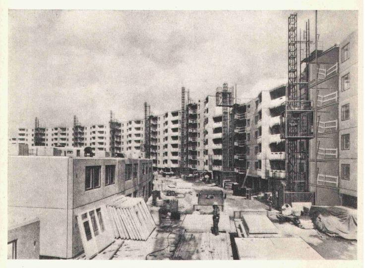
UM DIE KOSTEN DER ARBEITSKRÄFTE UND DER HANDHABUNG ZU REDUZIEREN UND DIE BAUTERMINE ZU KÜRZEN, BENÜTZEN AUCH SIE DEN BAULIFT Lambert ALIMAK C MIT ZAHNSTANGENSYSTEM.
