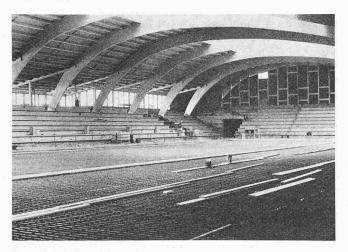
Die olympische Eislaufbahn in Annecy in Frankreich wurde als Schutz gegen Schäden in der Lauffläche durch Unterfrierungen auf einer 8 cm dicken Dämmschicht aus extrudiertem Polystyrol-Hartschaum aufgebaut. Die Aufnahme zeigt die Kühlrohre und die Stahlbewehrung über der Trennschicht aus einer doppelten Kunststoffolie
