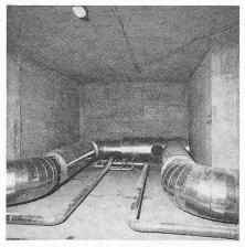
Bild 4. Kompensatorkammer im Tagbaukanal
