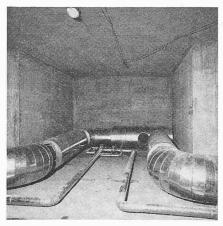
Bild 4. Kompensatorkammer im Tagbaukanal
