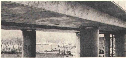
Bei Straßenbrücken aus Stahl oder in Massivbauweise sind Lager und Fahrbahnübergänge von maßgeblicher Bedeutung. Ihre Qualität beeinflußt wesentlich den Wert einer Brücke, ihre Sicherheit, Leistungsfähigkeit und Lebensdauer. Verformungen durch Temperaturänderungen, Winddruck und Verkehrslast müssen ausgeglichen, der Korrosionsgefahr entgegengewirkt werden.
