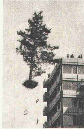
Versetzen von Bäumen
