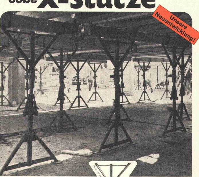
Für die Erstellung von Betondecken werden immer mehr vorbereitete Schalungselemente eingesetzt. Die Abstützung spielt dabei eine wesentliche Rolle. Sie soll wenig Arbeitsaufwand erfordern und anpassungsfähig
