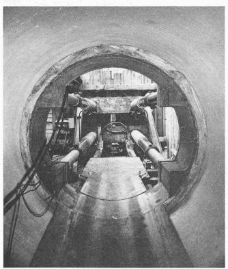
nötigen Hublänge für das Arbeitsspiel, die Länge des Überschieberings und den Rückfederausgleich von Widerlager und Rohrstrang einen Rohrvortrieb von maximal 3,30 m bei folgender Arbeitsweise:
