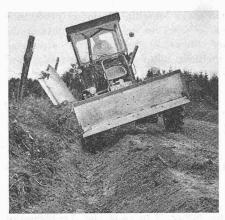
Bild 8. Andecken der Grabenaussenböschung und Fertigprofilierung mit ausgefahrener Schar
