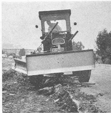
Bild 4. Auspflügen der vorgelockerten Tiefbordsteine mit der Schar
