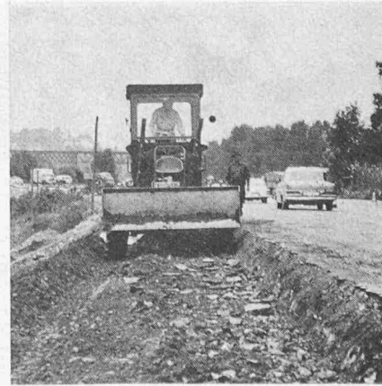
Bild 5. Fertigprofilierung der Auskoffierung
