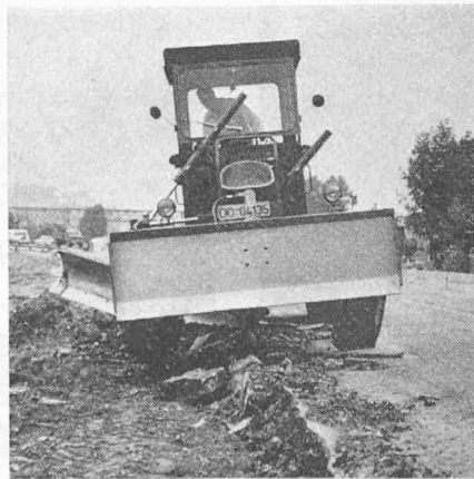
Bild 4. Auspflügen der vorgelockerten Tiefbordsteine mit der Schar
