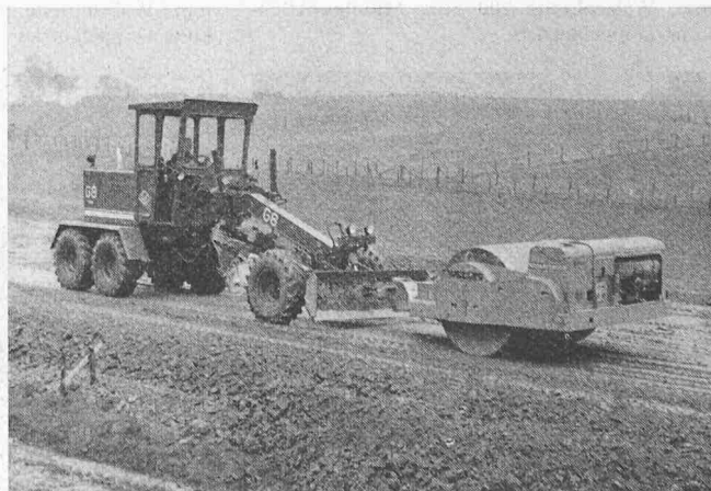
Bild 11. Grader G 8 mit schwerer Anhängerrüttelwalze bei der Verdichtung von Frostschutzkies
