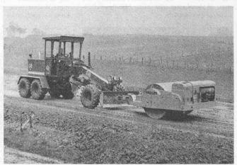
und Hersteller kann in dieser Hinsicht nützlich und gewinnbringend sein. Ein weiteres Beispiel für die Einsatzmöglichkeiten des Graders ist das Verdichten mit angehängter schwerer Rüttelwalze, Bild 11.
