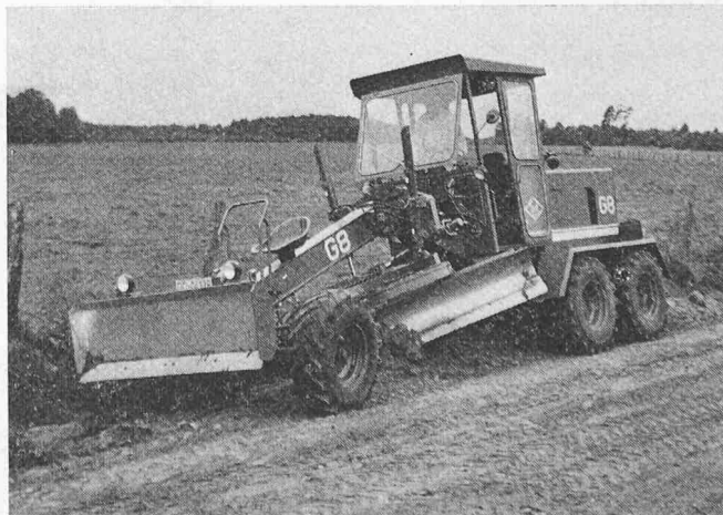
Bild 7. Abziehen der Grabeninnenböschung. Das Material legt sich auf der Böschungskante ab
