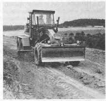
Bild 10. Fertigprofilieren mit der Hauptschar
