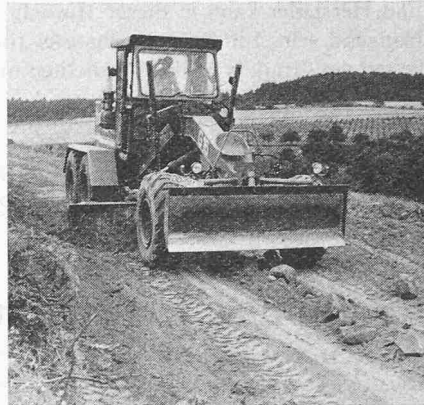
Bild 10. Fertigprofilieren mit der Hauptschar
