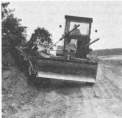
Bild 9. Herausreissen und Abschieben des Stubbens
