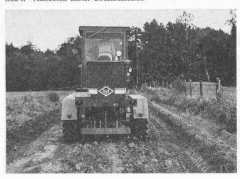
Bild 7. Abziehen der Grabeninnenböschung. Das Material legt sich auf der Böschungskante ab
