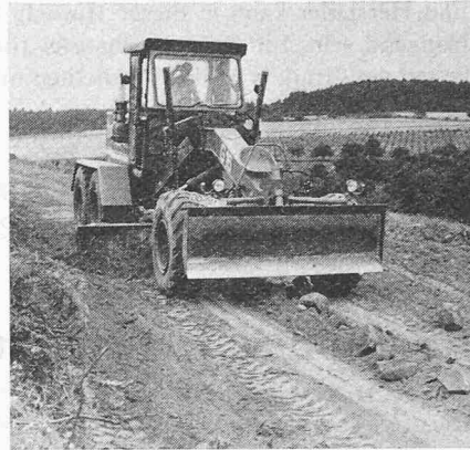
Bild 10. Fertigprofilieren mit der Hauptschar
