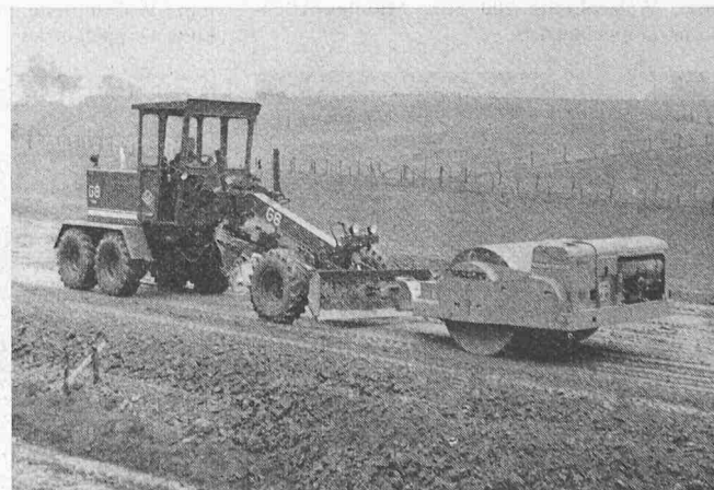
Bild 11. Grader G 8 mit schwerer Anhängerrüttelwalze bei der Verdichtung von Frostschutzkies
