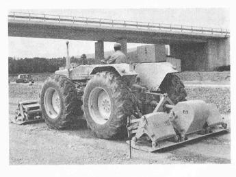
Bild 10. Stabilisierung der obersten Schicht des Unterbaues. Ammann-Kalkstreuer, gezogen von Allrad Ford-County; Rome-Scheibenegge
