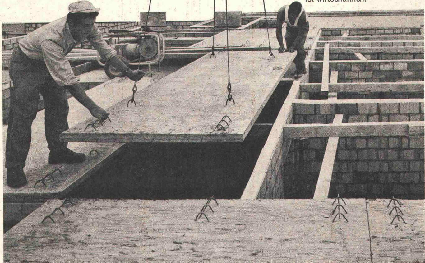
Prelam Deckenplatten sind vorgefertigt und werden am Bau verlegt. Sie übernehmen die Funktion der Deckenschalung und wirken als Träger der vorgespannten Hauptarmierung.
