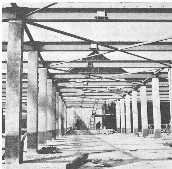
Fig. 3. Les piliers intérieurs en BA préfabriqué (Photos Roland Dougoud, Fribourg)
