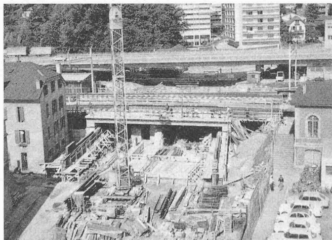
Construction des dalles aval, vue après ripage
