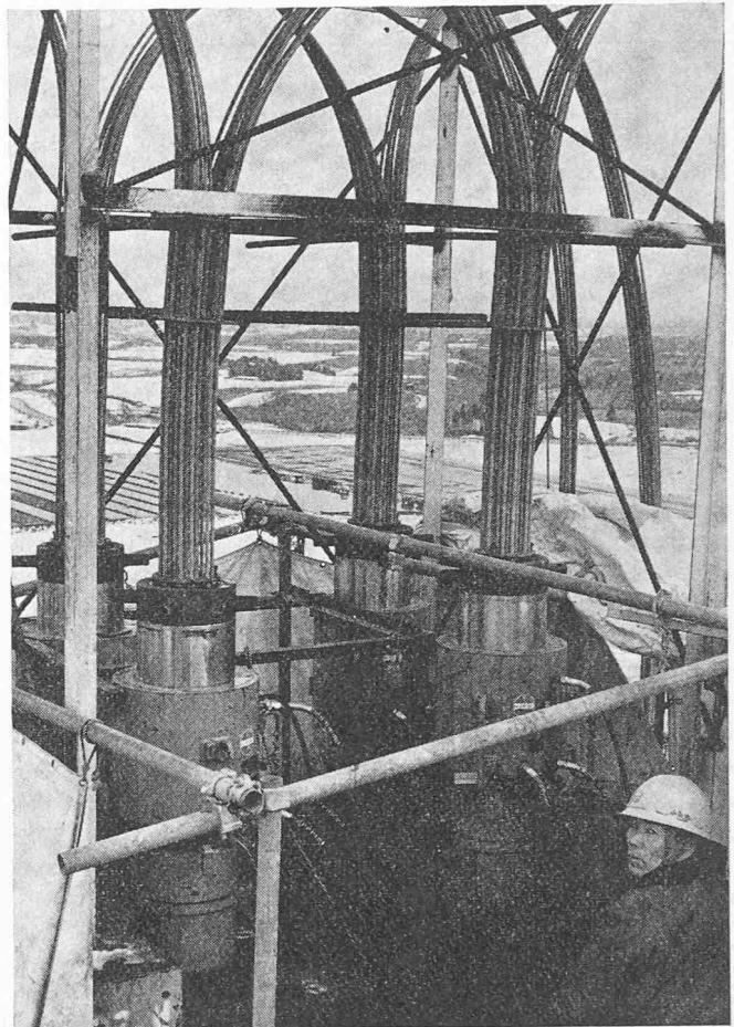
Bild 4. Vier VSL-Heber für insgesamt 840 t Hublast. Die oben heraustretenden Litzenbündel biegen um und hängen neben der Arbeitsplattform nach unten. Sie brauchen nicht fortwährend abgeschnitten zu werden
