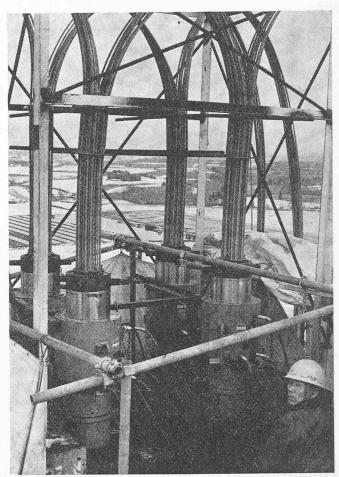
Bild 4. Vier VSL-Heber für insgesamt 840 t Hublast. Die oben heraustretenden Litzenbündel biegen um und hangen neben der Arbeitsplattform nach unten. Sie brauchen nicht fortwährend abgeschnitten zu werden
