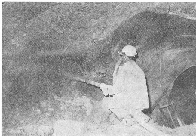
Bild 2 Aufbringen einer Ausgleichsschicht aus Spritzbeton auf die Ausbruchleibung
