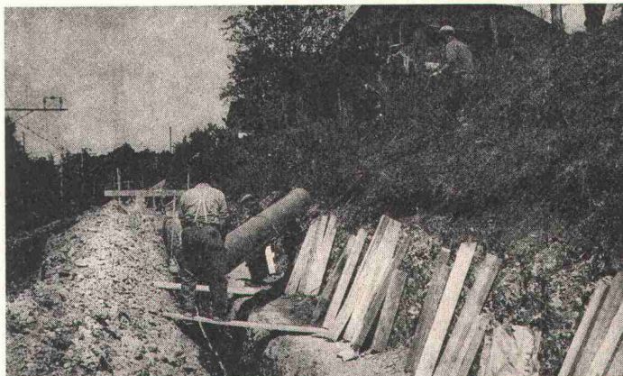
KALIDUR-Kanalisationsrohre, verlegt im Bahneinschnitt
