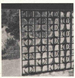
Der Chiaro-Glasbaustein eignet sich besonders im Innenausbau, als Eingangspartie, Windfang, Trennwand usw. und gibt jedem Bau eine besondere ästhetische
