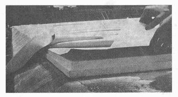
Oberer Abschluss des Eisfeldes; über der Dampfsperre eine Hartschaumisolationsplatte von 5 cm Stärke, die den dünnen Kieskoffer kompensiert. Es folgen: eine Gleitschicht, PVC-Folie als Wasserisolation, darüber Schutzmörtel und armierte Betonplatte mit Kühlrohren
