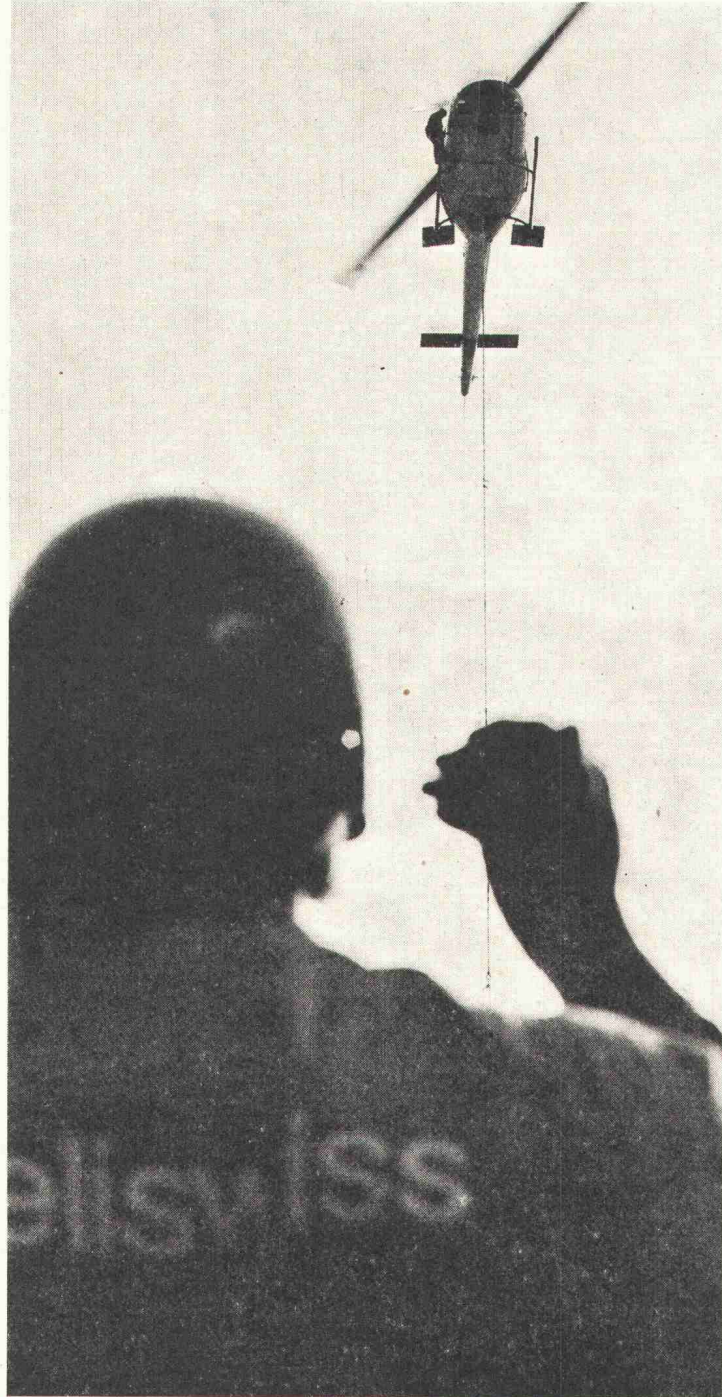
Einweisen einer Einzellast auf die Baustelle
