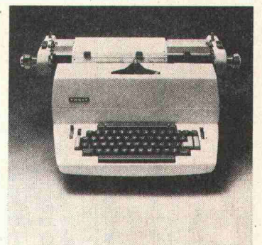
Ausgabe-Schreibmaschine Modell 9861A für die programmierte Ausgabe von Resultaten in Tabellenform.
