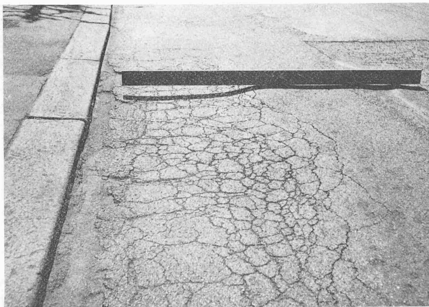
Bild 7. Stadtstrasse, Rillenbildung und Belagszerstörung.
