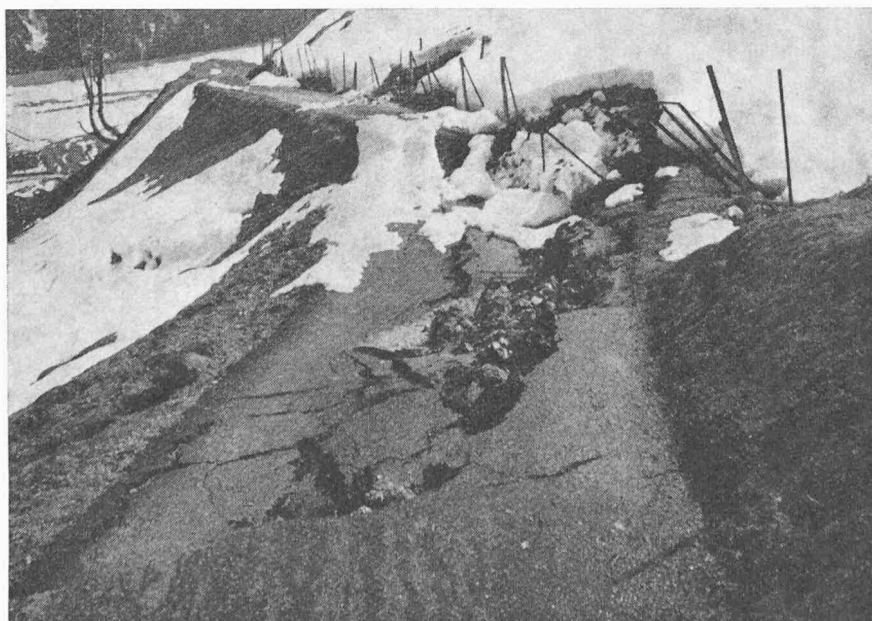
Bild 9. 200 m oberhalb eines Bauwerkes abgesackte Nebenstrasse. Der ganze Hang, mehrere Meter mächtige Lehme und verwitterte Gesteinsmaterialien umfassend, geriet in Bewegung.
