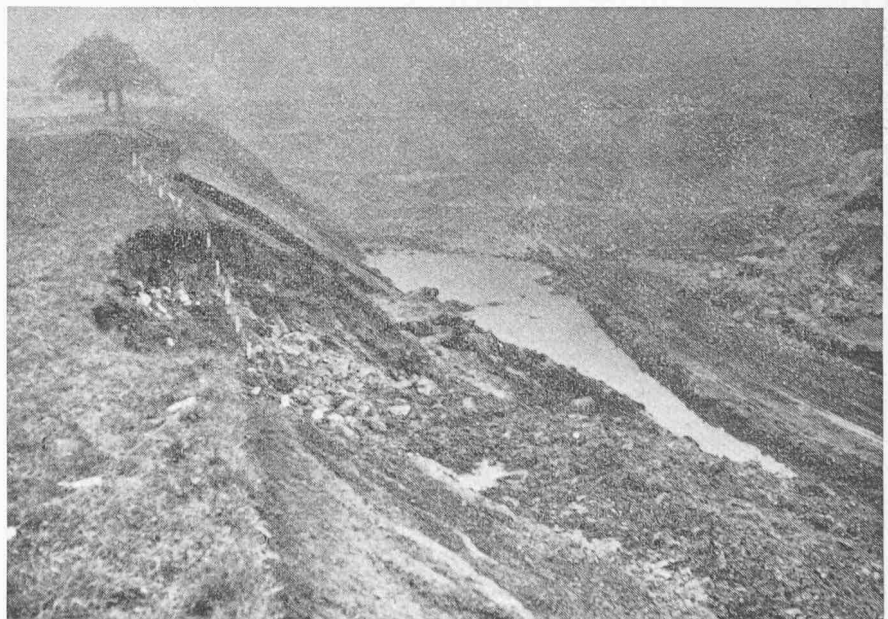
Bild 4. Gleiche Einschnittsböschung wie Bild 3
