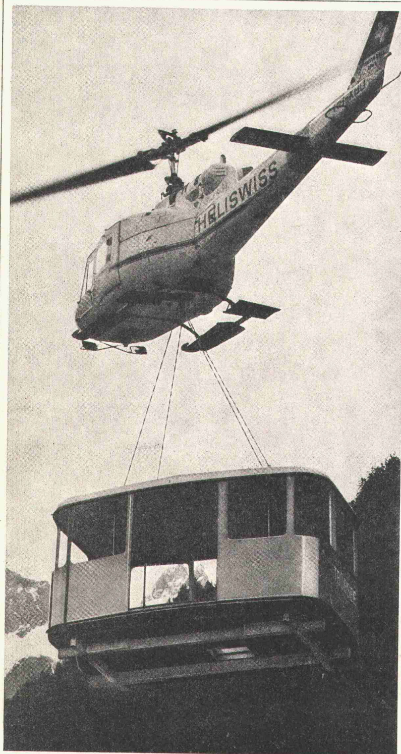
Kabinen-Transport der Trübsee-Titlis-Bahn
